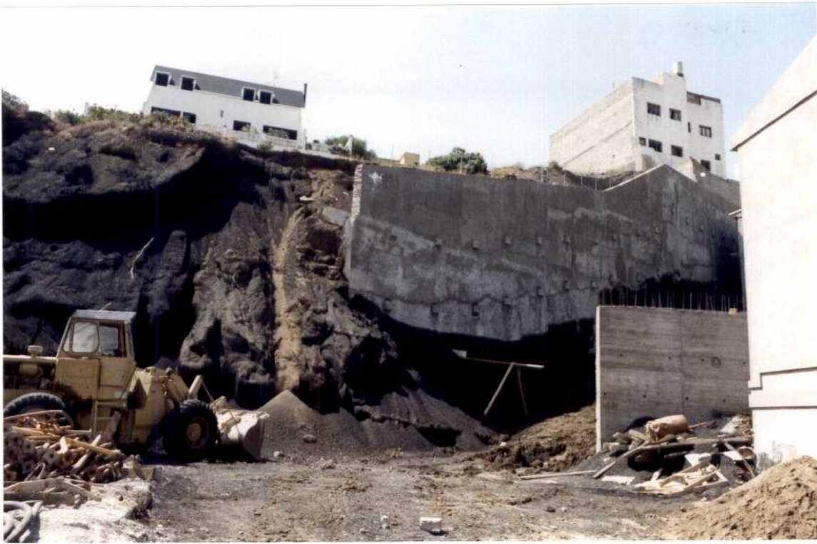
FOTOGRAFIA 7 : Vista de los enormes muros que se están realizando en los mismos materiales que los estudiados, en la Urbanización "Los Lentiscos".
